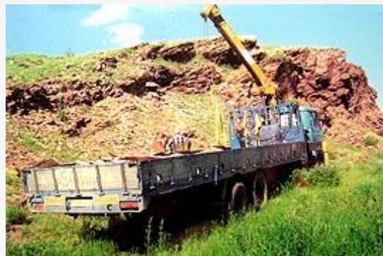
Разрушение памятника истории и культуры идет полным ходом.
